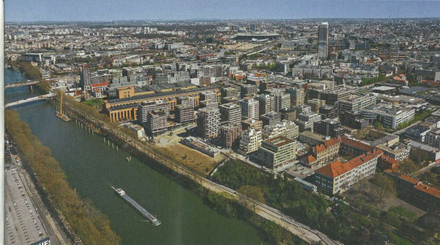
Sur les 21 Atex obtenues pour les ouvrages olympiques, 15 concernent des dispositifs d'ossature bois en façade mis en œuvre sur les immeubles du village des athlètes (situé au nord de Paris), sur la base de guides de recommandations initiés par la Solidéo.
