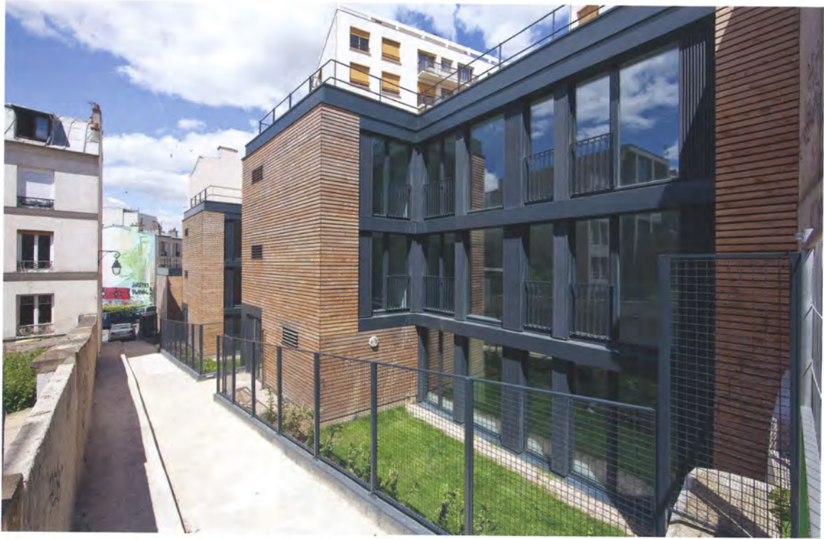
À Ménilmontant, 8 logements passifs en bois, prix AMO 2013 Spécial Fondation d'entreprise Excellence SMA. Architecte : Atelier Pascal Gontier. Maître d'ouvrage : RIVP. Menuiseries : Bieber. Entreprise générale : Fayolle. Photographe : Hervé Abbadie.
