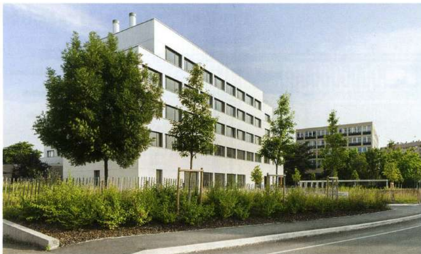
▲ D'ici, rien ne laisse deviner la structure en bois © Atelier Gontier
