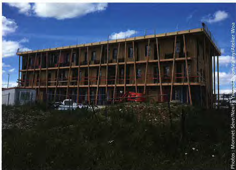
▲ Dijon-Valmy, immeubles de bureaux Ywood : poutres lasurées et poteaux en BL-C, planchers et murs intérieurs en CLT, laissés apparents et lasurés, en épicéa (Monnet-Sève). Architecte : Atelier Woa. Entreprise de charpente : Altibois Construction. Entreprise de préfabrication : Arbosphère.
