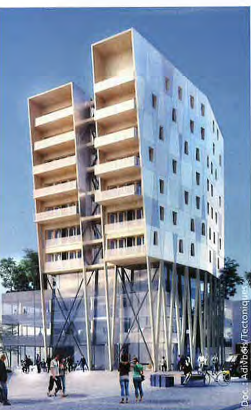
▲ L'immeuble Pop Up à Saint-Étienne, autre lauréat Adivbois, est constitué de planchers porteurs, d'une toiture-terrace, de cages d'escalier et d'ascenseur en CLT. Structure poteaux-dalles et plateaux réaménageables, assurant la réversibilité de la construction. Architectes : Tectoniques.
