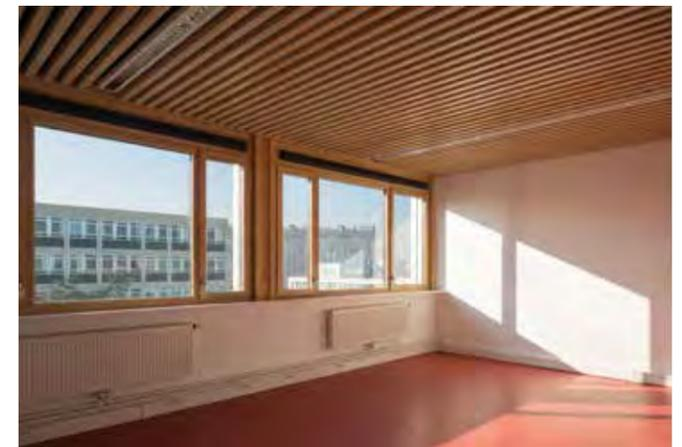
▲ Les fenêtres des bureaux sont équipées de stores extérieurs et de prises d'air en imposte. Les réseaux de chauffage et d'électricité sont majoritairement disposés le long des murs de façade pour préserver la flexibilité du plan.
