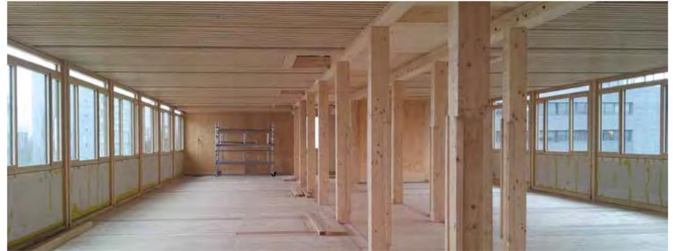
▲ Dans les étages courants, les couloirs distributifs s'insèrent logiquement entre les deux files de poteaux-poutres qui constituent des lignes d'appuis intermédiaires sur lesquelles reposent les planchers.
