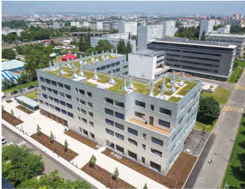
▲ La cinquième façade est traitée avec un complexe isolation étanchéité, mis en œuvre sur une dalle bois (CLT) et recouvert d'une végétalisation.
