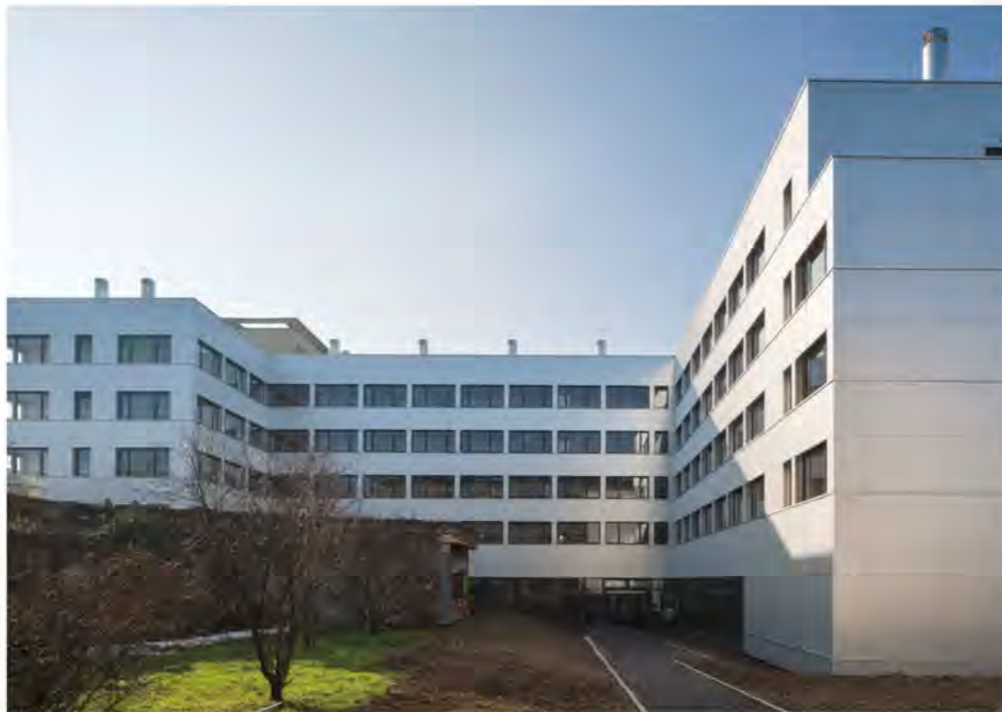
▲ La structure répond au standard PassivHaus, avec une forte isolation des parois pleines (160mm de laine de roche) et une réduction maximum des ponts thermiques structurels.
