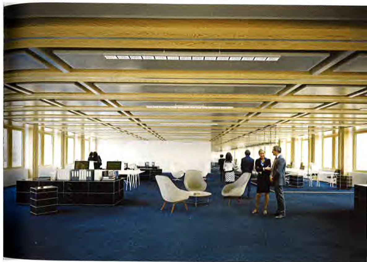
Bâtiment de bureau Paris 17* (Atelier Pascal Gontier) Conception dalles préfabriquées bois-béton avec intégration de panneaux rayonnants réversibles, liberté de cloisonnement à la carte suivant une trame longueur-largeur, sans modification du second œuvre et des équipements © perspective Arte Factory
