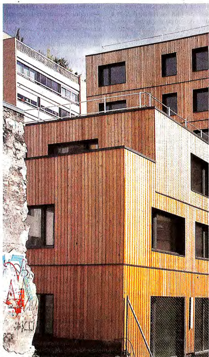
Dans le nouveau bâtiment de Pascal Gontier, à Paris, tous les logements, du studio au 5-pièces, sont multi-orientés, sinon traversants.
