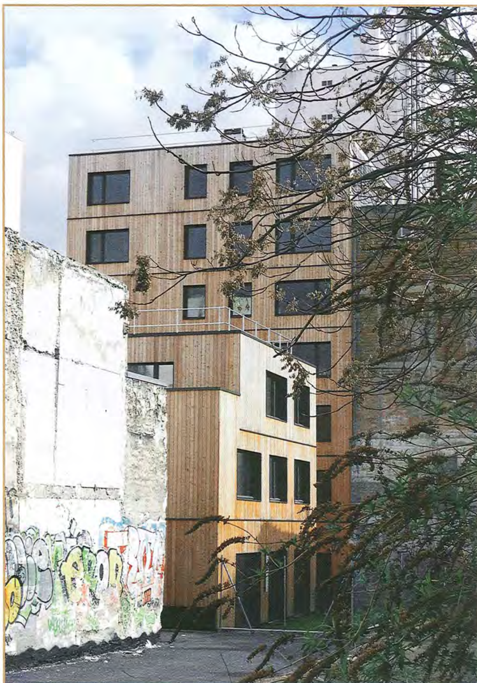
Façades vues de la cour. Ph. © Pascal Gontier.
