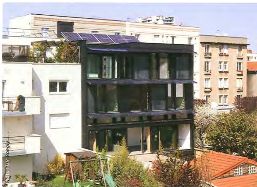
Maison Gaïta, façade sud ; Issy-les-Moulineaux (92).
