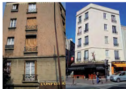
Avant/après : immeuble situé rue Estienne d'Orves.
