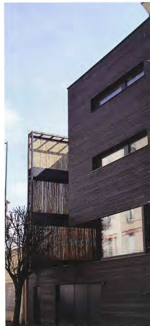
L'ossature du bâtiment a été dessinée de façon à éviter tout pont thermique. Les murs en bois, le toit végétalisé et les dalles de béton dans les planchers assurent une parfaite isolation hiver comme été.
