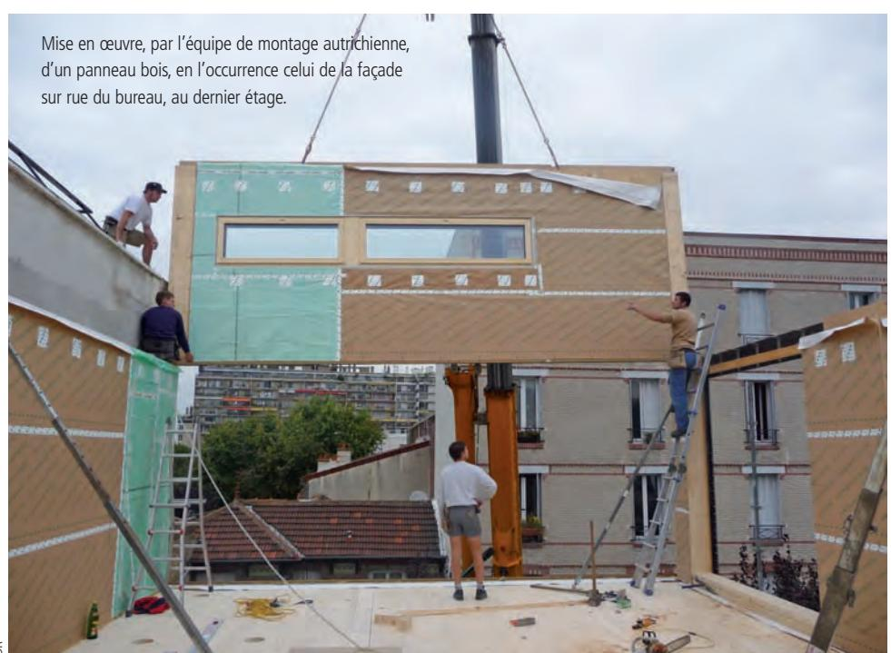
Mise en œuvre, par l'équipe de montage autrichienne, d'un panneau bois, en l'occurrence celui de la façade sur rue du bureau, au dernier étage.
