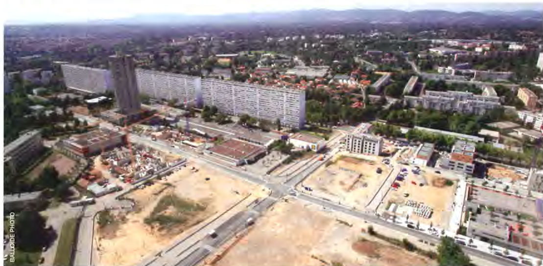
Le chantier de rénovation de La Duchère à l'été 2008. Plusieurs barres de logements ont été démolies pour tracer l'axe transversal permettant de mieux relier le quartier à l'Ouest lyonnais.
