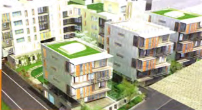
9 600 m 2 de terrasses végétalisées répartis sur 10 programmes de logements et le gymnase
